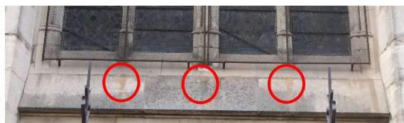
Appui baie chapelle 32 (traces de rouilles)
